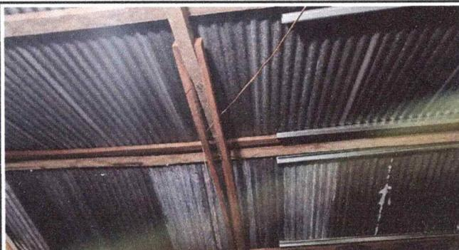
Foto 3: La sustitución de la estructura se debe a que la actual se encuentra en mal estado, pudiendo ocasionar algun accidente.
