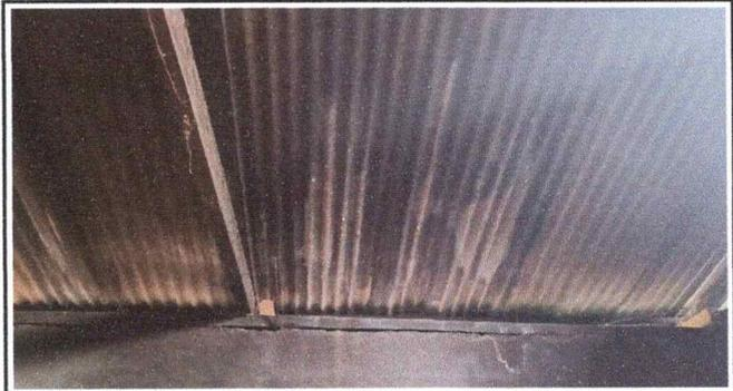
Foto 4: Se contempla la sustitucion de cubierta de lamina debido a que la actual lamina ya presenta orificios provocados por el desgaste que provoca la interperie
