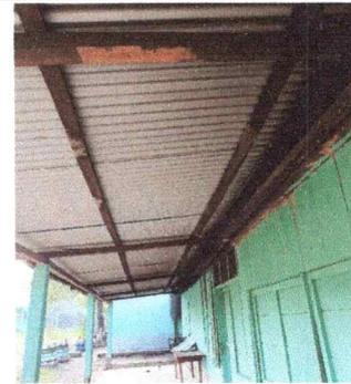
Foto 2: La sustitución se realizara por el mal estado de la madera debido al tiempo que lleva.
